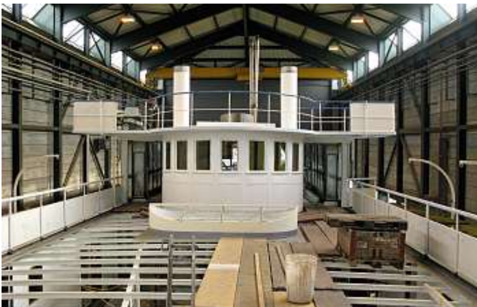
Das Oberdeck des Dampfschiffes erhält ein komplett neues Deck.
