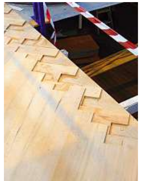
Es entsteht ein kreuzverleimtes Holzdeck.
